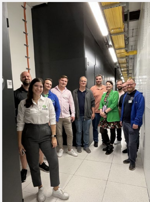
Mit Wasabi bei der Equinix-Rechenzentrumstour in Frankfurt am Main
